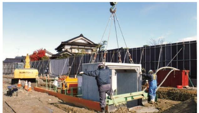
布設函渠吊降ろし状況
