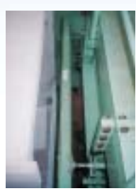
OSJ機の 函渠押し付け装置
