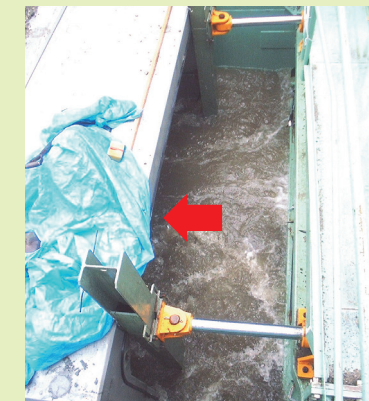
②OSJ機内から敷設済みBox-Cへの流入・排水処理
