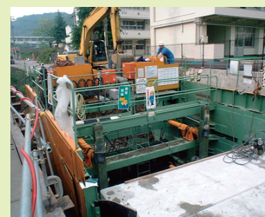
施工状況（通常時）
