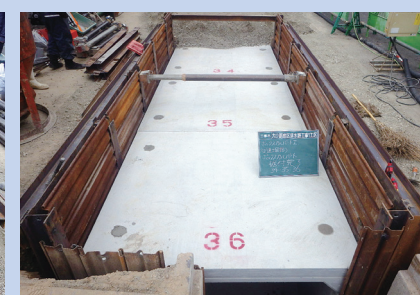
土留め枠内 函渠布設完了
