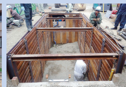
土留め枠工 全景
