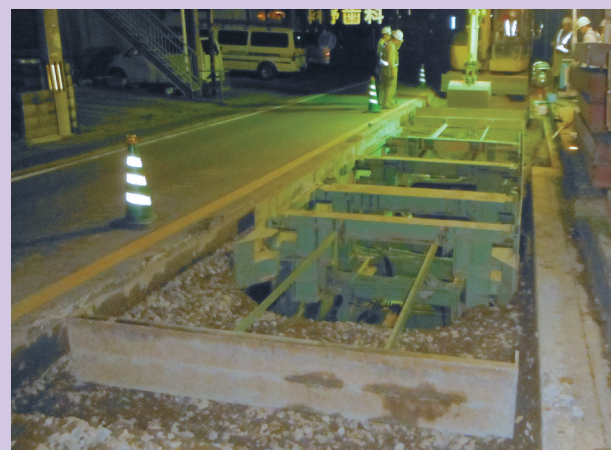
覆工ユニット架設
