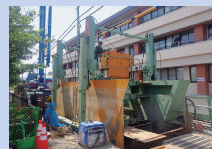
区間到達部 OSJ機自昇工
