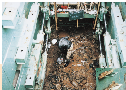
転石・玉石層の状況
