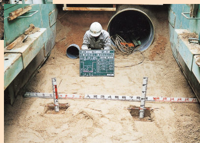
左右並設管渠の布設状況
