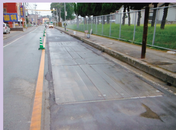
覆工板設置（交通開放）
