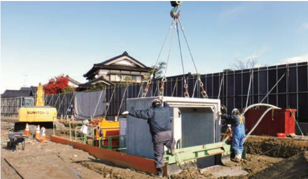
布設函渠吊降ろし状況
