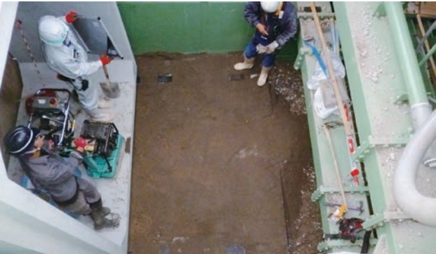
敷モルタル敷均し状況
