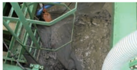
システム・機内ポンプ併用で排水 (排水量0.08m³/分)
