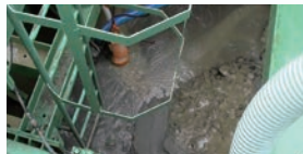
機内ポンプのみで排水 (排水量0.34m³/分)
