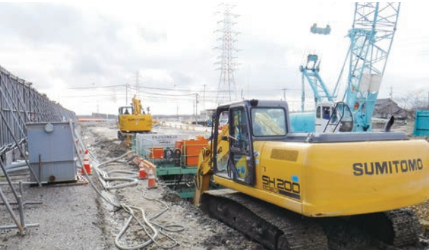
掘削、埋戻し、掘進状況
